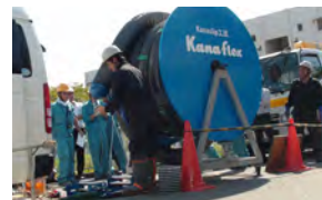
ドラムを設置
