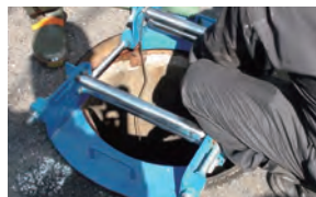
上部ガイドローラーを設置
