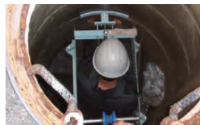
下部ガイドローラーを設置
