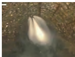
支障物を処理
