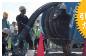
本管を引き込む
