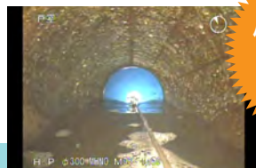
供用下施工状況
